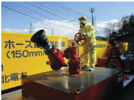
放水砲の放水方向調整
