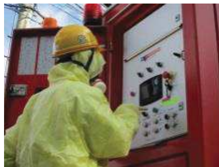
大容量送水ポンプ（タイプⅡ）の起動
