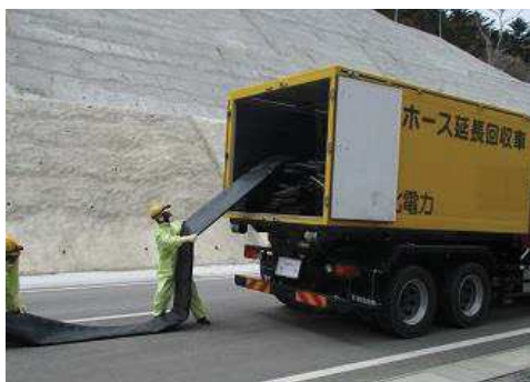
ホース敷設，接続
