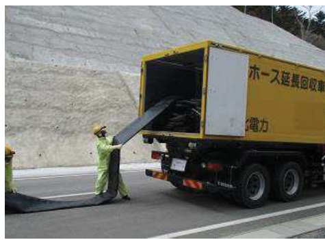
ホース敷設，接続
