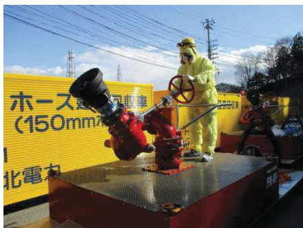
放水砲の放水方向調整
