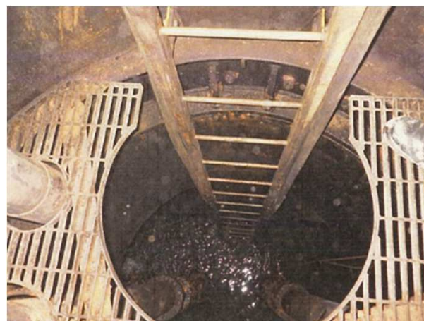
写真C 揚水井戸⑦（下段部） 2017/3/16撮影
