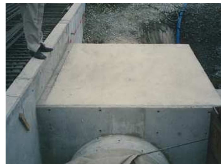
写真3-4 2号炉原子炉建屋周囲接続桧の例
