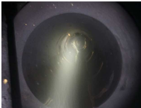
写真A ドレーン（有孔ヒューム管φ800mm） 2018/9/18撮影
