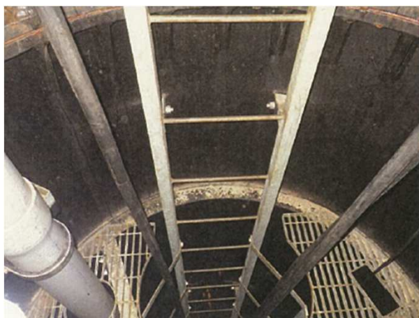
写真B 揚水井戸⑦（中間部） 2017/3/16撮影
