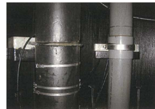
写真3-6 3号炉配管の例(左側) (揚水井戸⑦)
