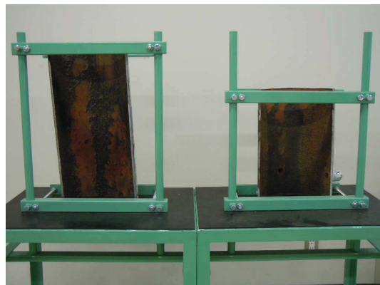
女川1号炉 復水浄化系配管の減肉
