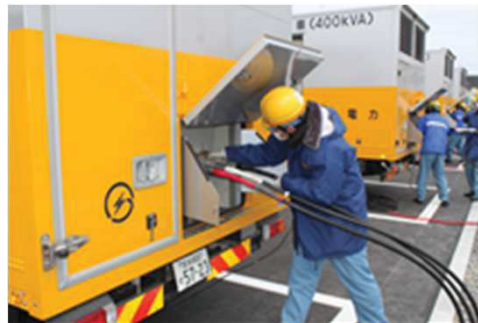
電源車の接続訓練
