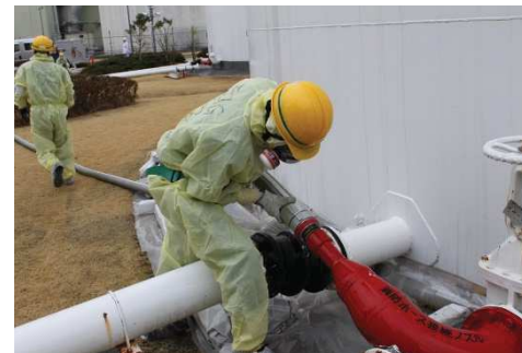
注水ホース接続訓練
