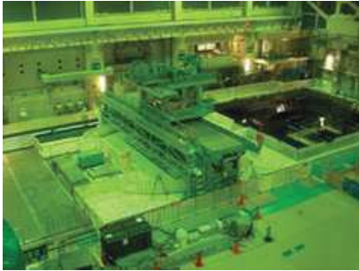
原子炉建屋原子炉棟運転床全体
