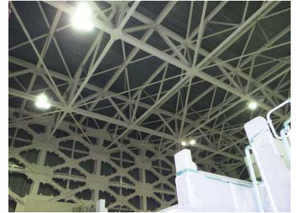
原子炉建屋原子炉棟運転床天井
