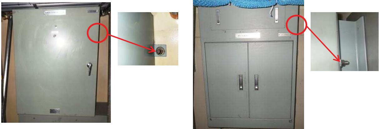
図2 電源盤のボルトによる壁面固定
