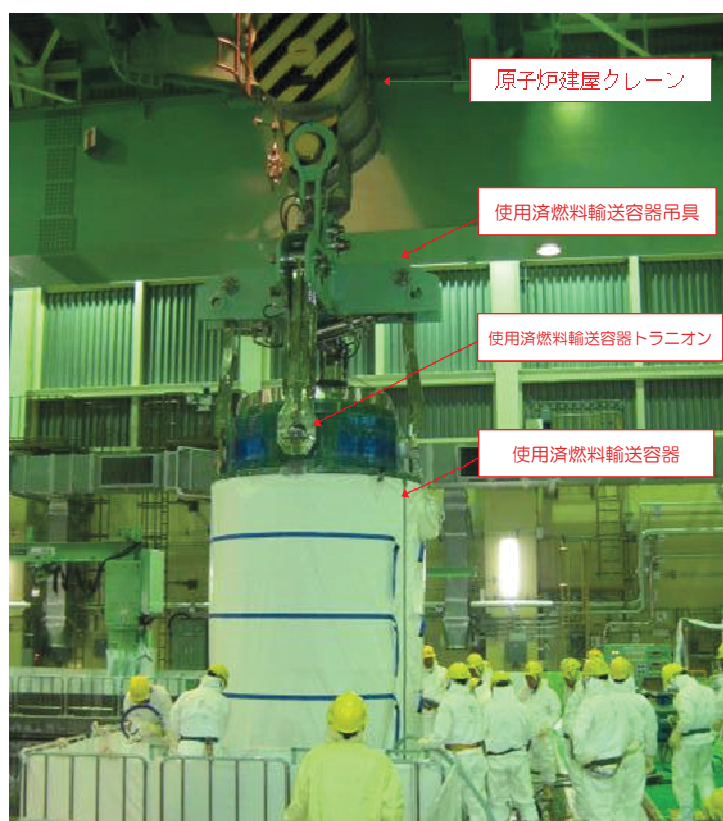
図 1 使用済燃料輸送容器吊具の現場での使用状況
