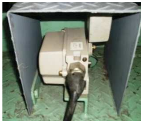
図 5.2.16 過巻防止用リミットスイッチ (主巻, 補巻上装置)
