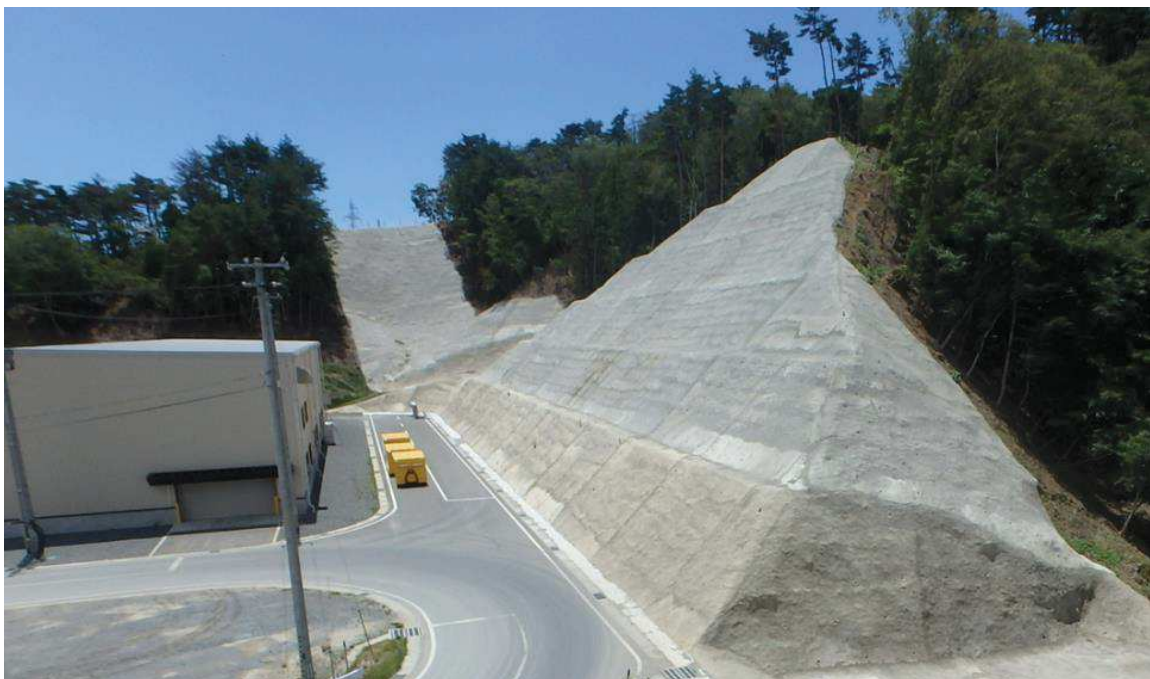
第1図 防火帯モルタル吹付工の施工例
