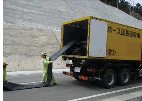
ホースの敷設、接続
