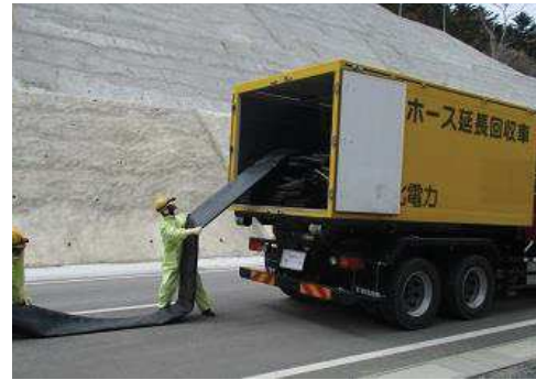
ホース敷設，接続
