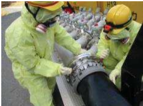
注水用ヘッダへのホース接続
