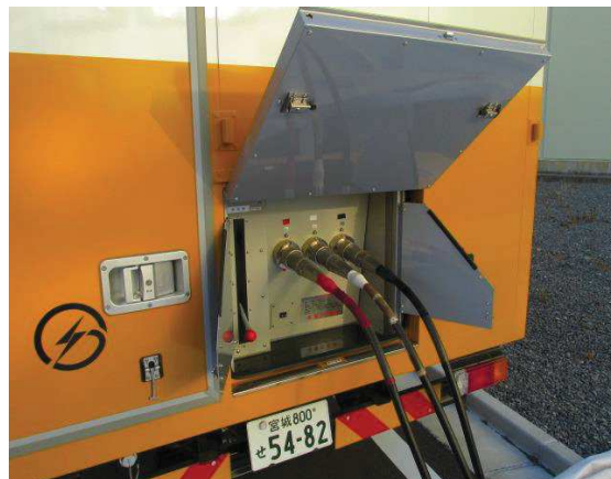
電源車ケーブル接続
