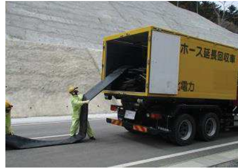
ホース敷設，接続
