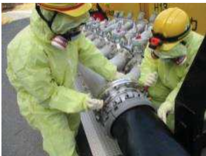
注水用ヘッダへのホース接続
