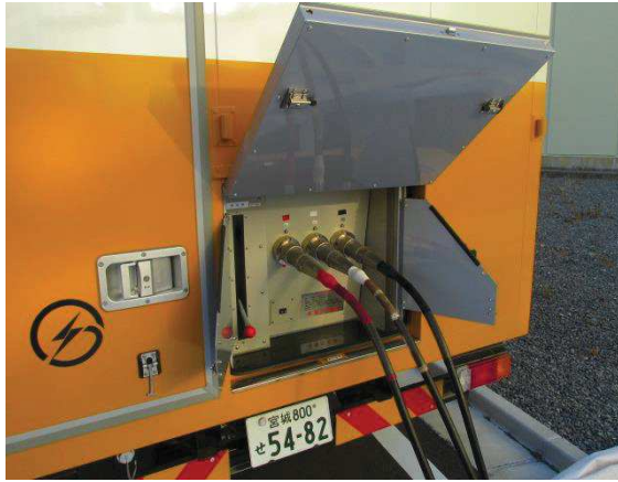
電源車ケーブル接続
