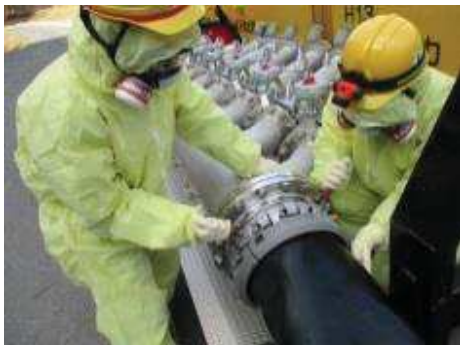
注水用ヘッダへのホース接続
