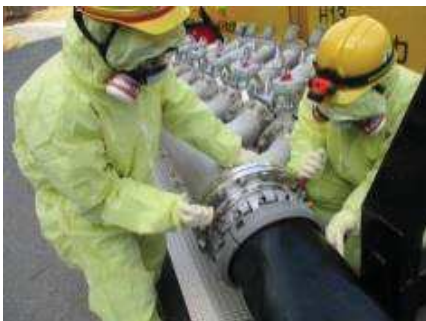
注水用ヘッダへのホース接続
