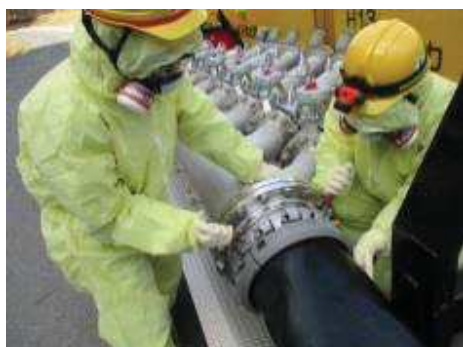
注水用ヘッダへのホース接続
