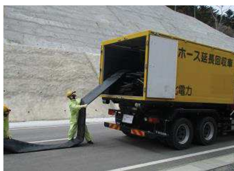
ホース敷設，接続
