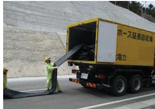
ホースの敷設，接続
