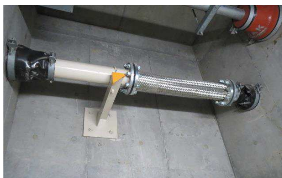
第 41-1-30 図 地盤変位対策の実施例
