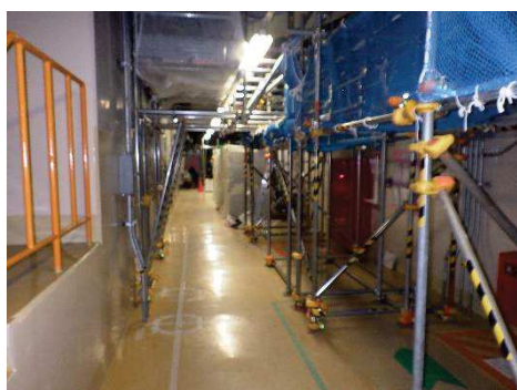
※足場や養生は仮設設置
