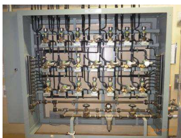
電磁弁架台
