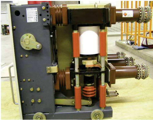
メタクラ 種類：真空遮断器
