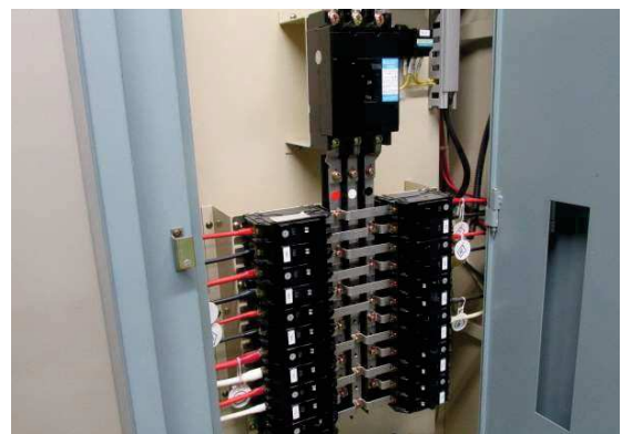
ブレーカ 種類：配線用遮断器
