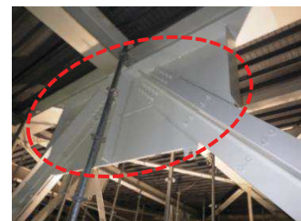
屋根トラス接合部の補強状況写真
