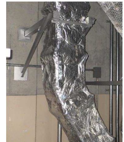
埋め込み金物設置状況 (空調ダクト:耐震Sクラス)
