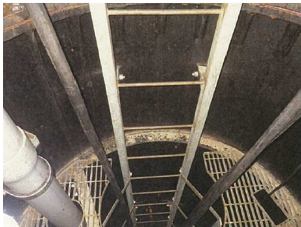
写真B 揚水井戸⑦（中間部） 2017/3/16撮影
