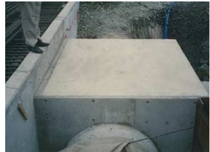
写真① 2号炉原子炉建屋周囲接続桧の例
