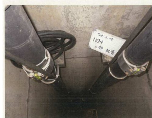
2号炉配管の例(揚水井戸④)
