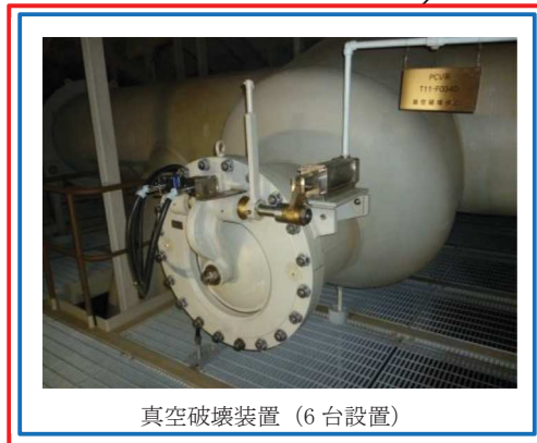
图 50-4-17 真空破壞裝置設置位置图
