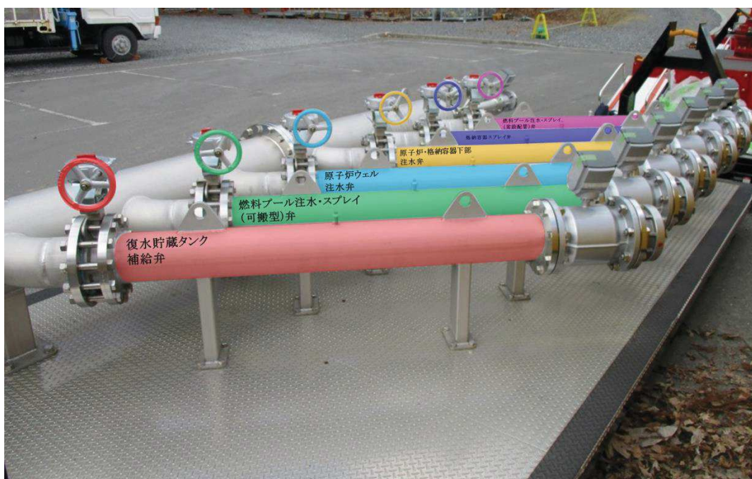
図 49-12-3 注水用ヘッドの誤接続及び誤操作の防止対策イメージ図
