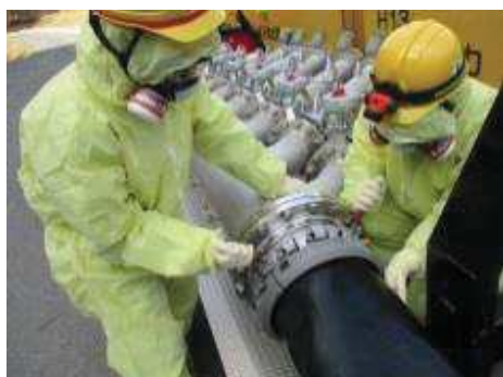
注水用ヘッダへのホース接続
