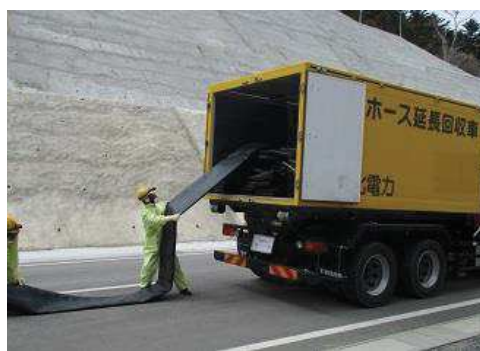
ホース敷設、接続
