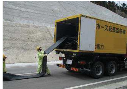
ホースの敷設，接続
