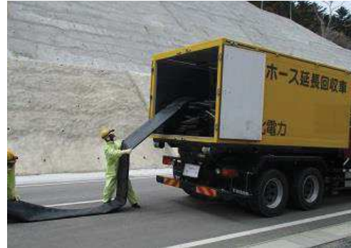
ホースの敷設、接続
