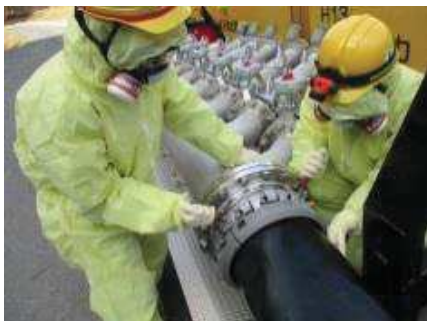
注水用ヘッダへのホース接続
