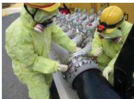
注水用ヘッダへのホース接続
