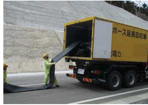
ホース敷設、接続
