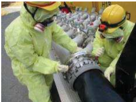
注水用ヘッダへのホース接続
