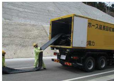
ホースの敷設，接続
