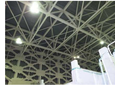
原子炉建屋原子炉棟運転床天井
