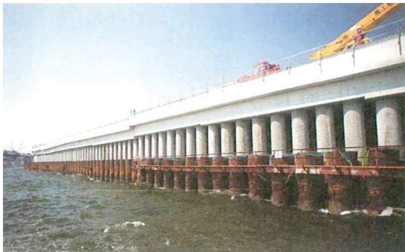
羽田空港D滑走路消波護岸
