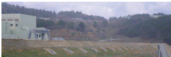
既設防潮堤完成状況(平成24年4月26日)
