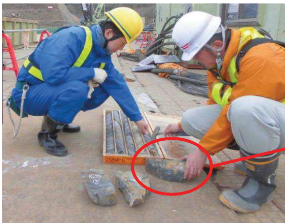
女川防潮堤の鋼管杭施工時における岩盤確認状況
