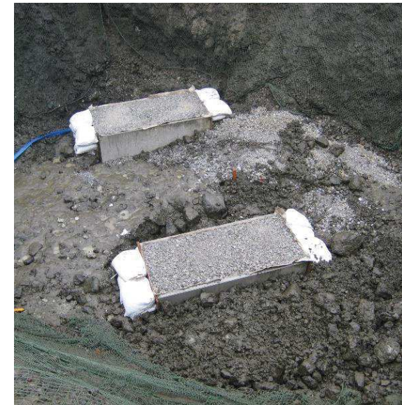
ドレーン(U字溝)設置状況
