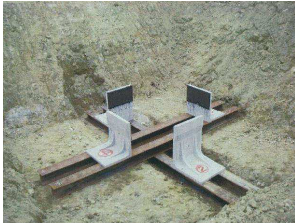
L字擁壁設置状況
