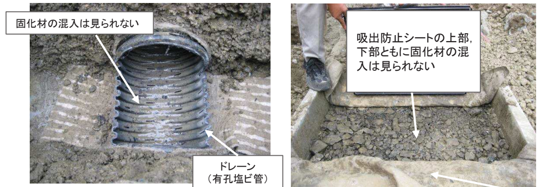
地盤改良後のドレーン及びフィルター材状況 (改良体中心～ドレーン中心:3.0m)
