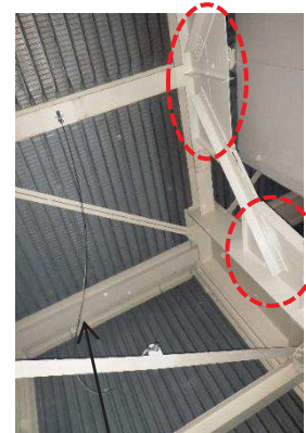
(水平ブレースの落下防止ワイヤー)
