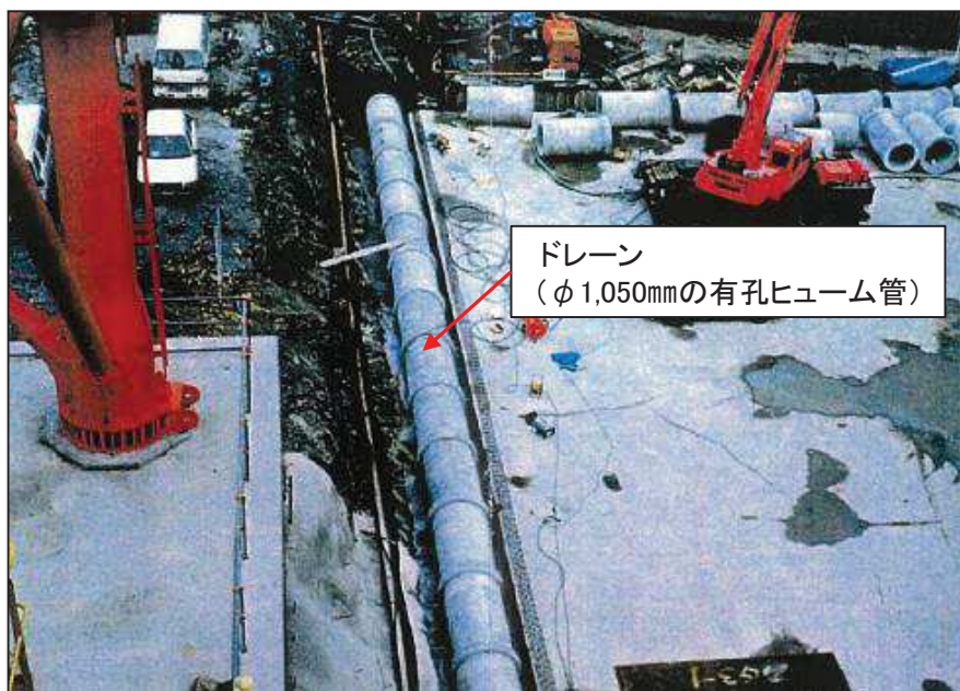
写真A 2号炉原子炉建屋北側ドレーン(φ1,050mmの有孔ヒューム管)
