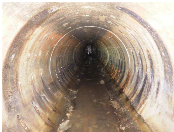
写真A ドレーン（有孔ヒューム管Φ1,050mm） 2018/9/18撮影
