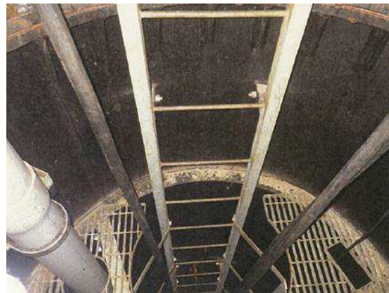
写真B 揚水井戸⑦（中間部） 2017/3/16撮影
