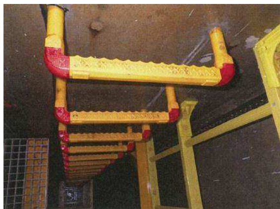
写真C 揚水井戸⑤（中段部） 2017/3/17撮影
