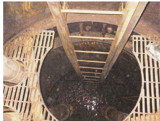
写真C 揚水井戸⑦（下段部） 2017/3/16撮影
