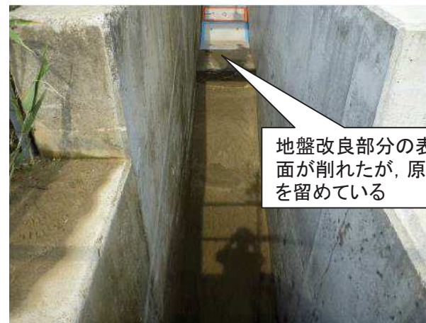
◆ ケース5-2-2m(地盤改良あり)の試験終了後状況
