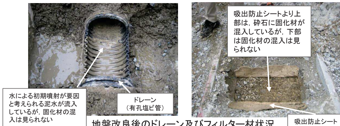
地盤改良後のドレーン及びフィルター材状況 (改良体中心～ドレーン中心:0.7m)
