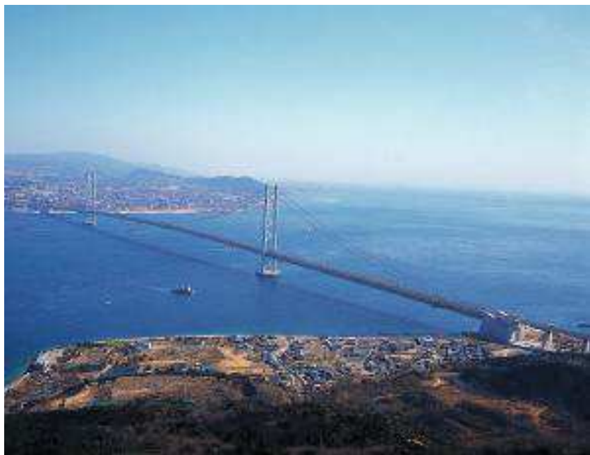
明石海峡大橋
