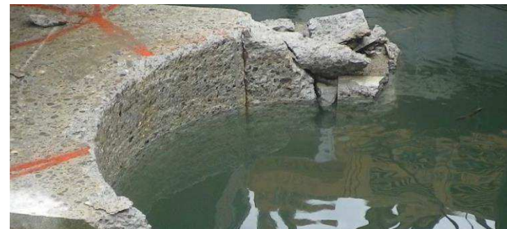
オールケーシングによるコンクリートの掘削面
