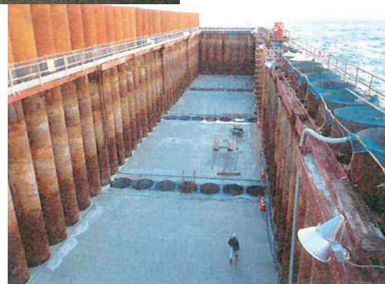
水中不分離コンクリート打設後の状況
