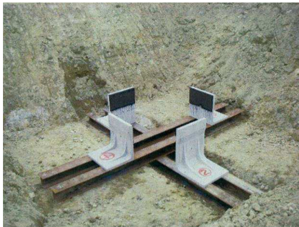
L字擁壁設置状況
