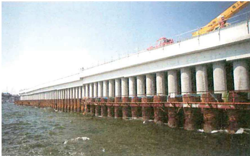
羽田空港D滑走路消波護岸
