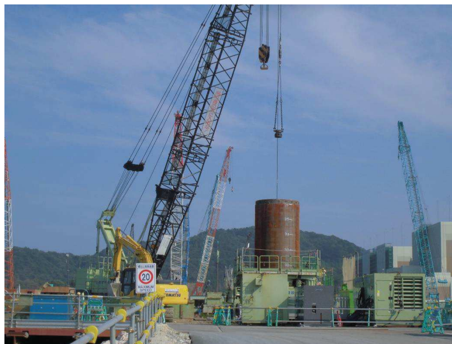
オールケーシング工法の施工例 (女川防潮堤)
