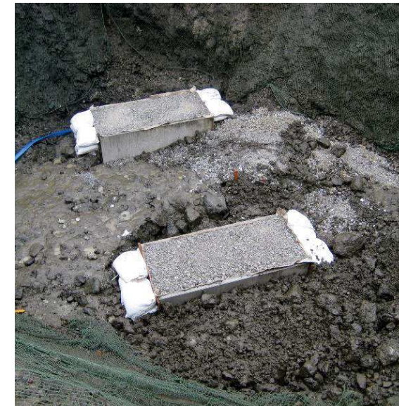
ドレーン(U字溝)設置状況
