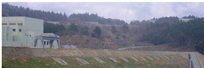
既設防潮堤完成状況(平成24年4月26日)
