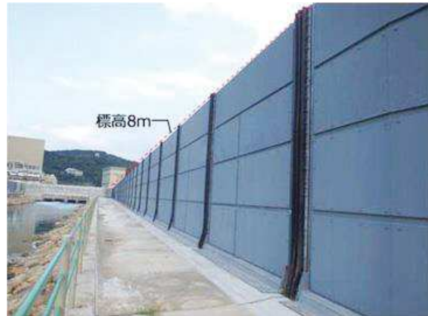
関西電力(株)高浜発電所 防潮堤 (出典:関西電力(株)HP)
