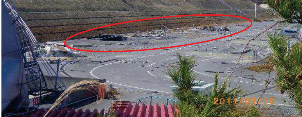
写真①: 岸壁全体の漂流物状況(平成23年3月18日撮影)
