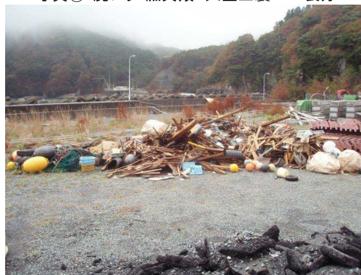
写真③: 混合ゴミ 約140m 3
