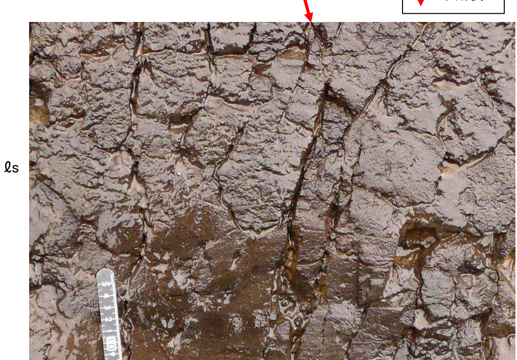
③ 小断裂は屈曲し, 一部は開口している
