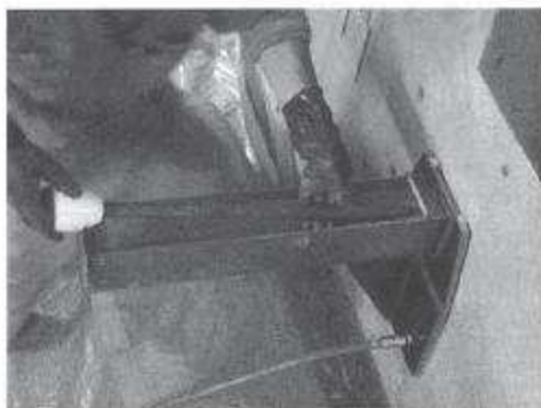
「セラミックキャップバー (CCb)」の挿入
