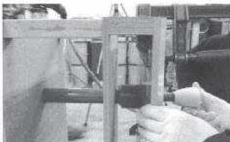
「セラミックキャップバー (CCb)」の挿入
