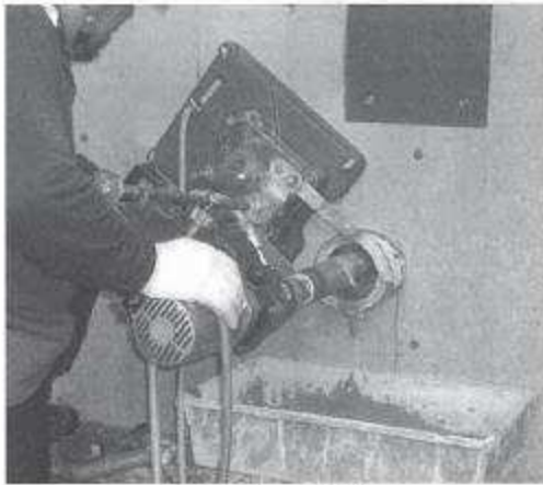
RC 部材への削孔
