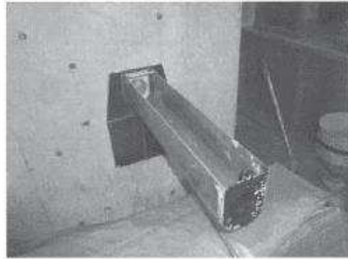
グラウト貯留槽の設置
