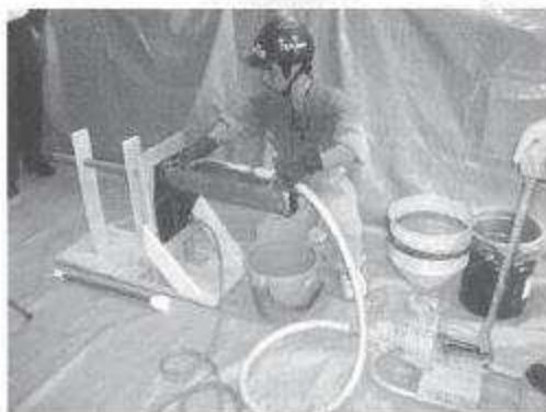
グラウトの充てん状況
