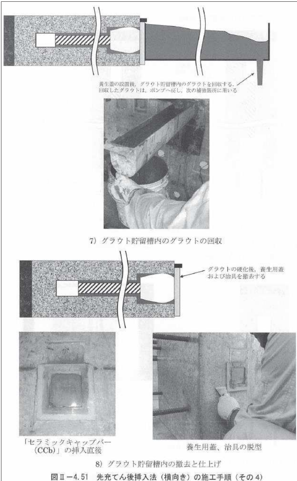
図表 3-14 CCb の施工手順の設定 (建設技術審査証明報告書より抜粋) (8/14)
