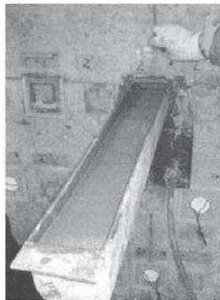
図Ⅱ-4.50 先充てん後挿入法 (横向き) の施工手順 (その3)
