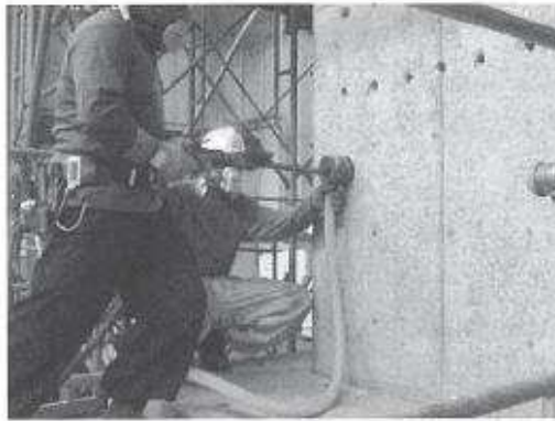
レッグハンマーによる削孔
