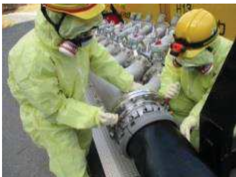
注水用ヘッダへのホース接続
