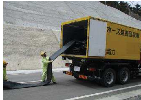
ホース敷設, 接続
