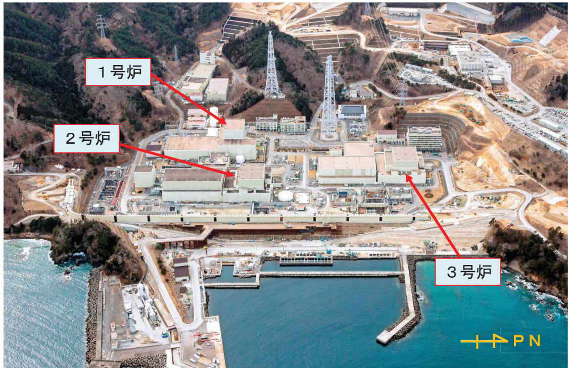
図 1.2-2 女川原子力発電所の全景
