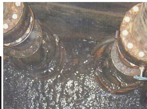
揚水ポンプ据付状況の例（井戸⑥）
