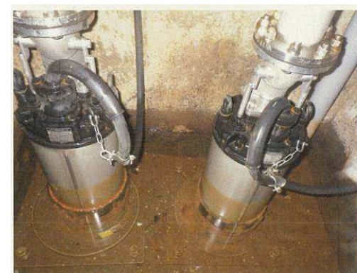
揚水ポンプ据付状況の例（井戸③）
