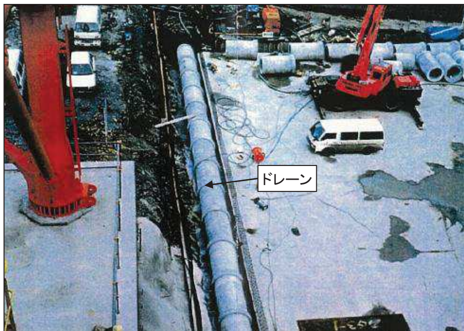
2号炉原子炉建屋北側ドレーン φ1,050有孔ヒューム管(写真A)
