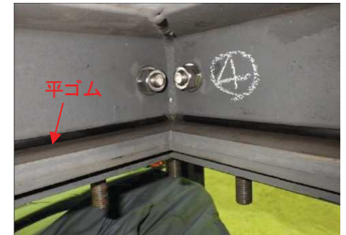
耐圧試験状況-止水目地⑤
