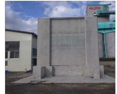
(試験施工状況)
