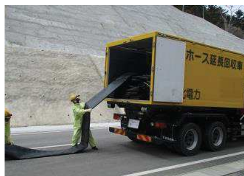
ホース敷設, 接続
