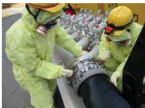
注水用ヘッダへのホース接続
