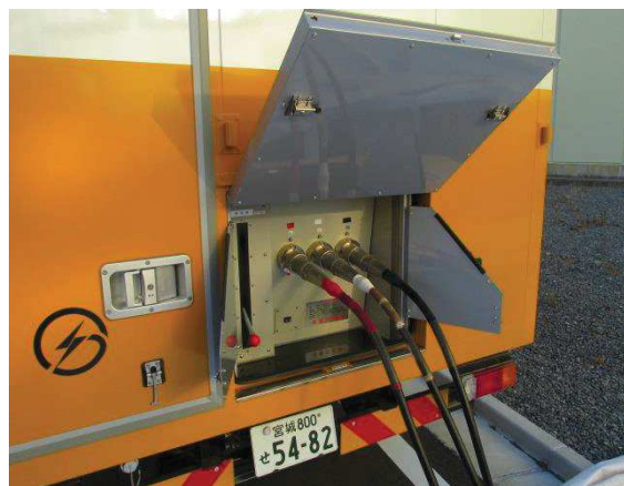
電源車ケーブル接続
