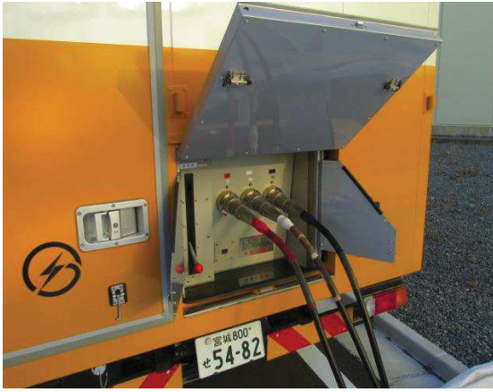
電源車ケーブル接続
