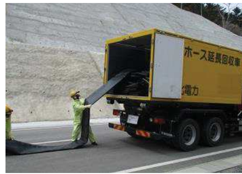
ホース敷設，接続
