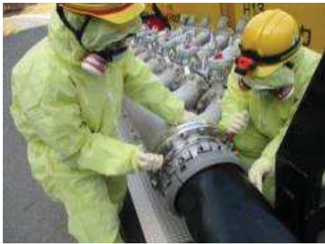
注水用ヘッダへのホース接続
