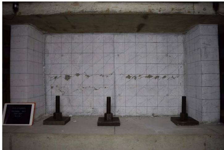
せん断すべり破壊している。
