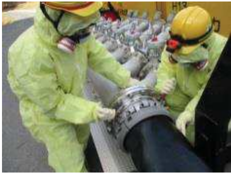
注水用ヘッダへのホース接続
