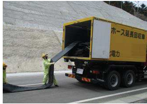
ホース敷設, 接続
