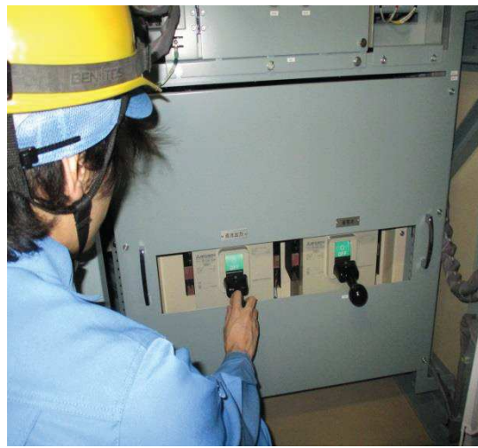
代替蓄電池の切操作
