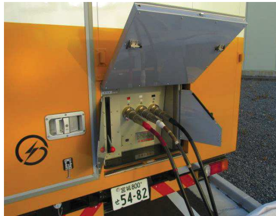
電源車ケーブル接続
