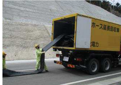
ホースの敷設、接続
