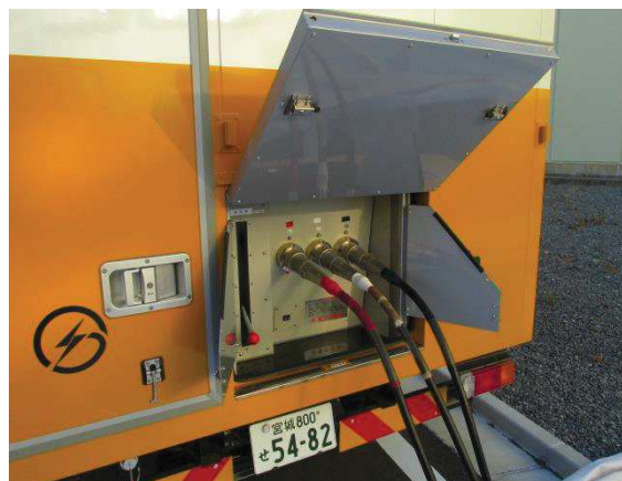
電源車ケーブル接続
