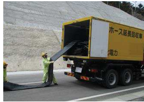
ホース敷設，接続
