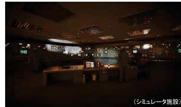
図11 室内照明全消灯時における 可搬型照明(SA)の点灯状況
