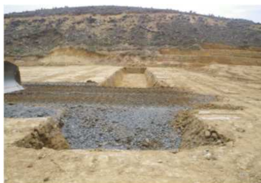
写真4 作業完了状況
