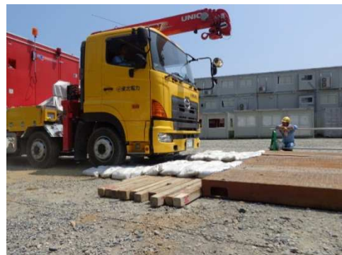
大型車両通行状況
