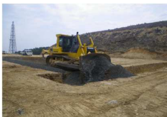
写真2 碎石運搬・埋め戻し状況
