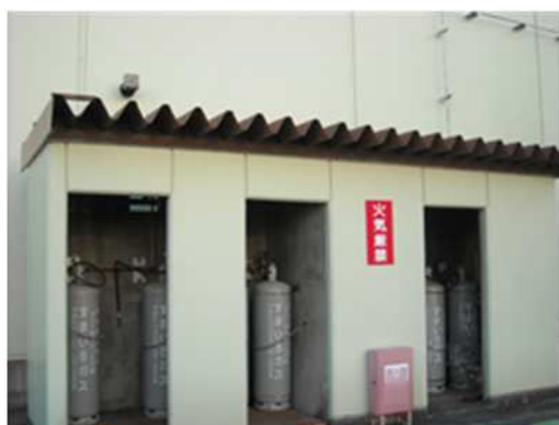
1号タービン発電機用ガスボンベ庫（水素ガス）
