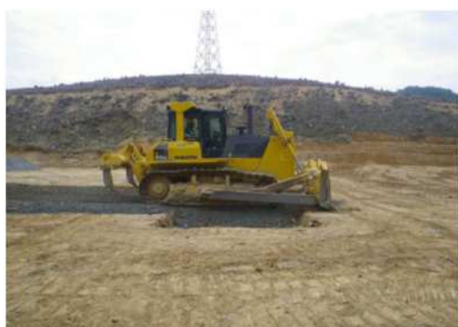
写真3 碎石運搬・埋め戻し状況
