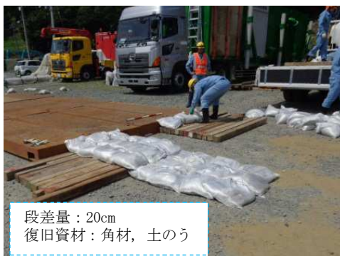
段差復旧作業状況
