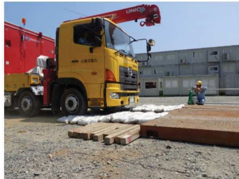
大型車両通行状況
