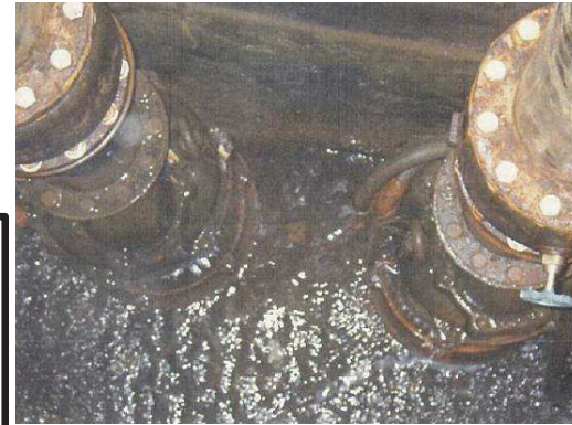
ポンプ据え付け状況の例(井戸⑥)
