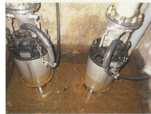
ポンプ据え付け状況の例(井戸③)
