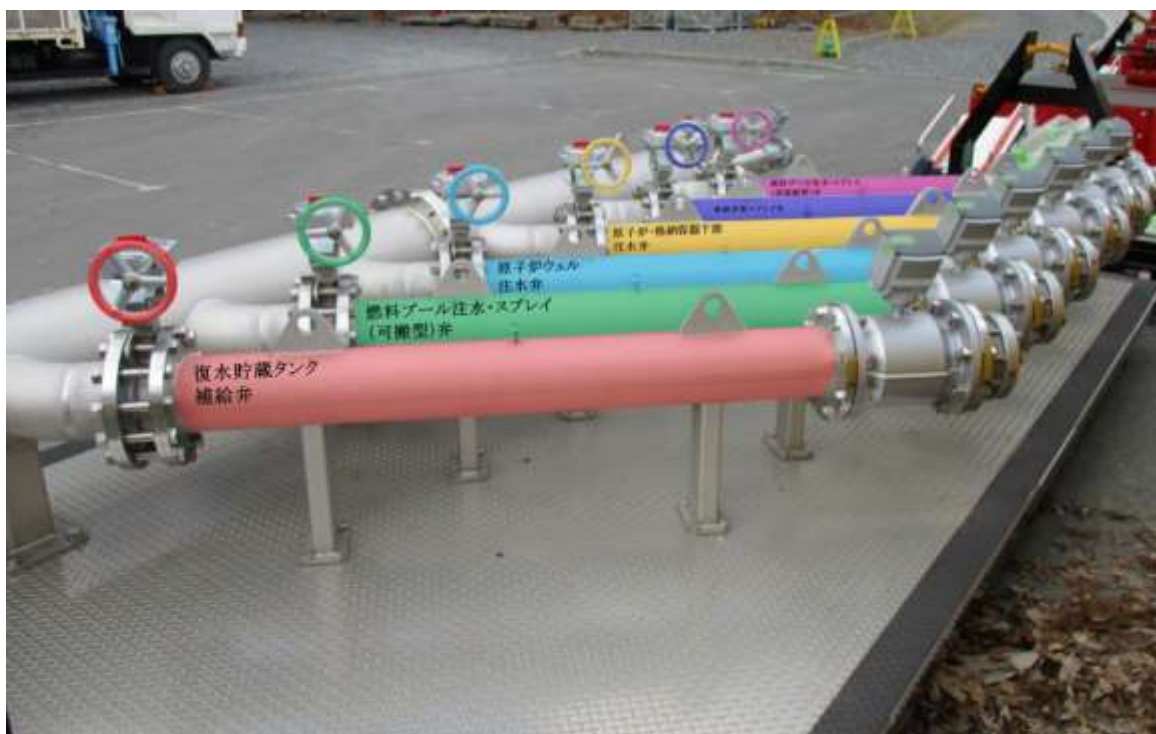
図 56-9-3 注水用ヘッドの誤接続及び誤操作の防止対策イメージ図
