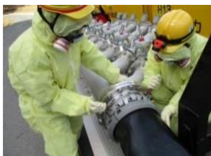
注水用ヘッダへのホース接続
