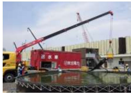
水中ポンプの設置（訓練）
