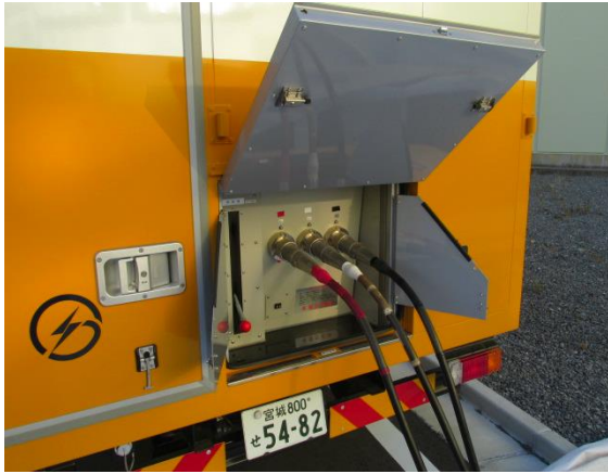
電源車ケーブル接続
