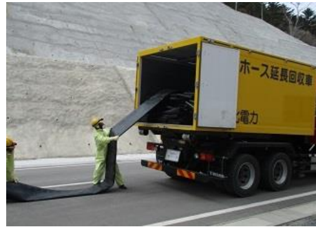
ホース敷設、接続
