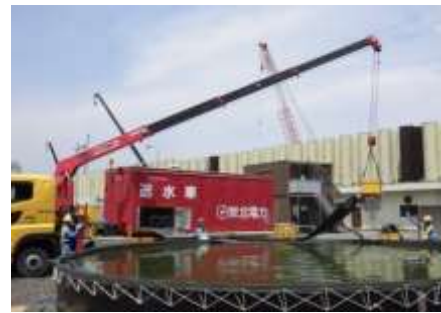
水中ポンプの設置（訓練）
