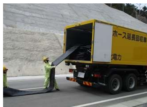
ホース敷設, 接続
