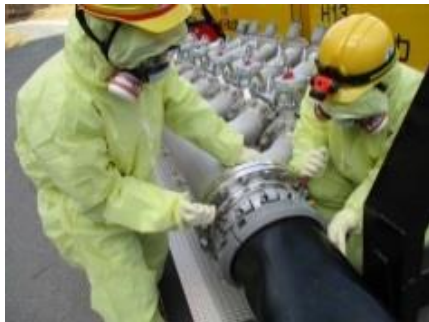
注水用ヘッダへのホース接続
