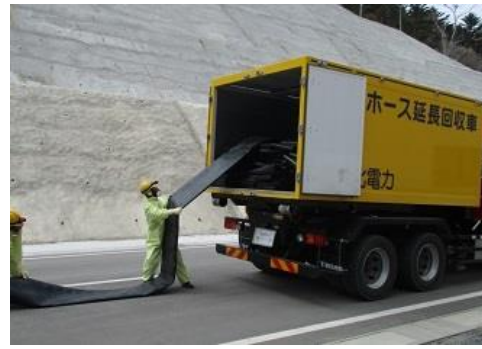
ホース敷設，接続（屋外）
