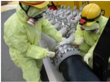
注水用ヘッダへのホース接続
