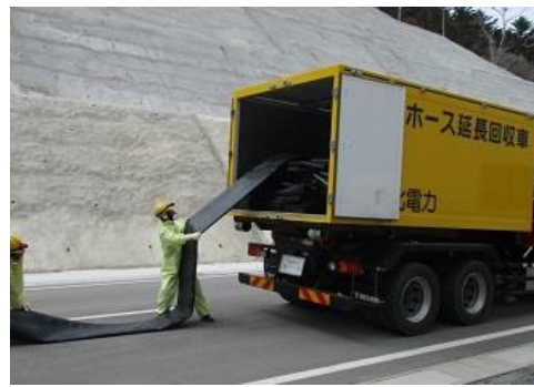
ホース敷設, 接続
