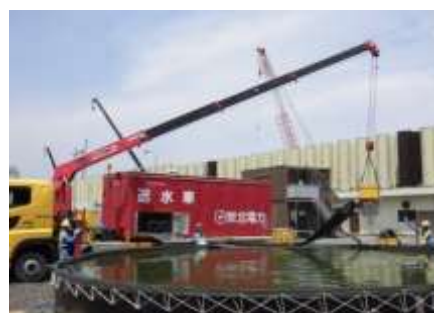
水中ポンプの設置 (訓練)
