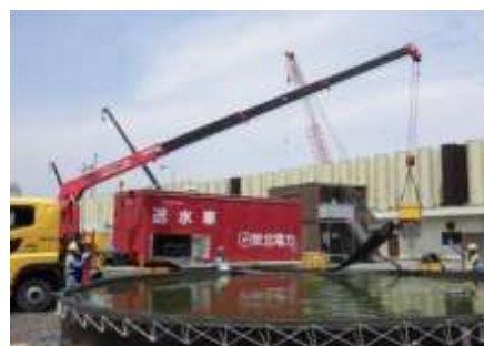
水中ポンプの設置（訓練）
