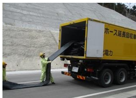
ホースの敷設，接続
