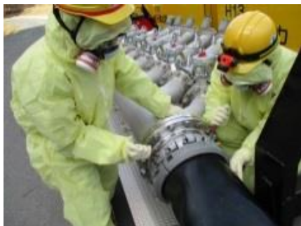
注水用ヘッダへのホース接続
