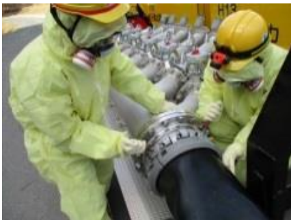
注水用ヘッダへのホース接続
