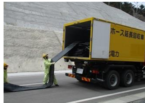
ホース敷設, 接続
