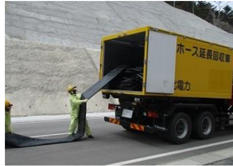
ホース敷設，接続（屋外）
