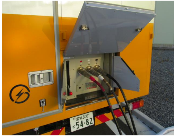
電源車ケーブル接続
