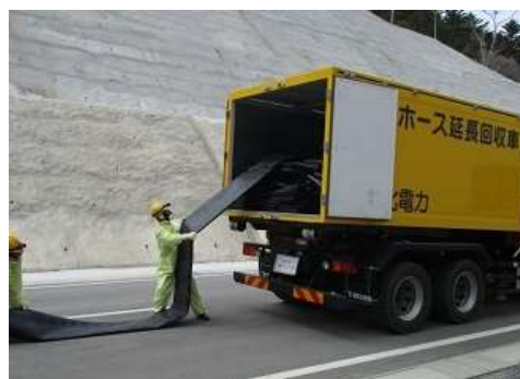
ホース敷設、接続
