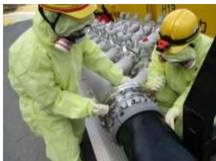
注水用ヘッダへのホース接続
