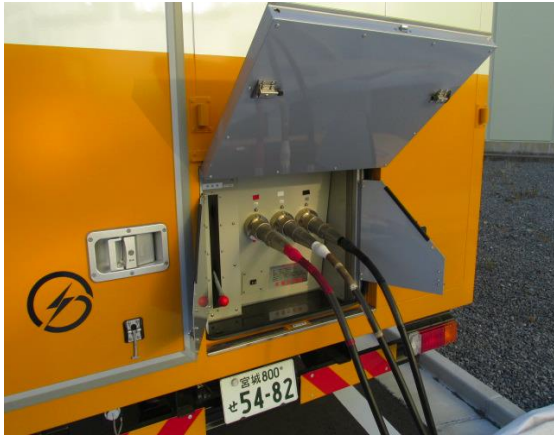
電源車ケーブル接続
