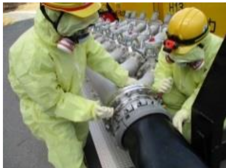
注水用ヘッダへのホース接続
