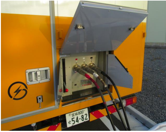
電源車ケーブル接続
