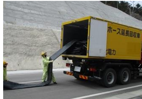
ホースの敷設，接続
