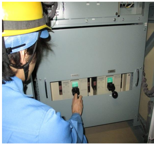
代替蓄電池の切操作
