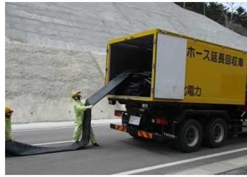
ホース敷設，接続
