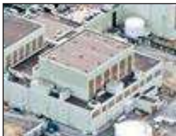
図7-1-1 原子炉建屋の状況
