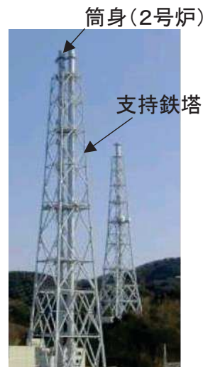
図7-5-1 排気筒の状況
