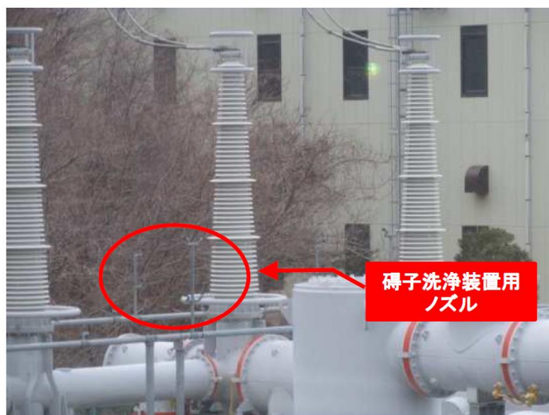
第 2. 2. 4-35 図 碍子洗浄装置外観
