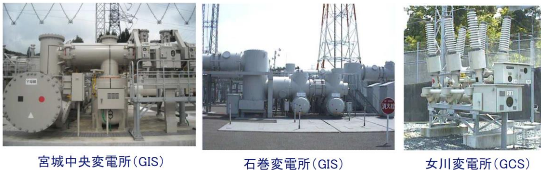
第 2. 2. 4-10 図 変電所の GIS, GCS
