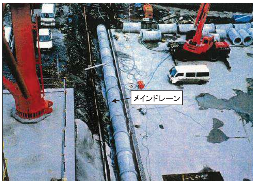
2号炉原子炉建屋北側 メインドレーン φ1,050有孔ヒューム管(写真A)
