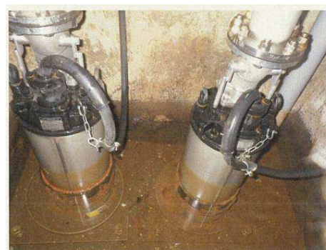
ポンプ据え付け状況の例(井戸③)
