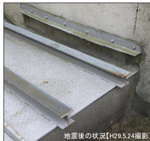
←1号炉SPTとT-11トレンチの接続部
