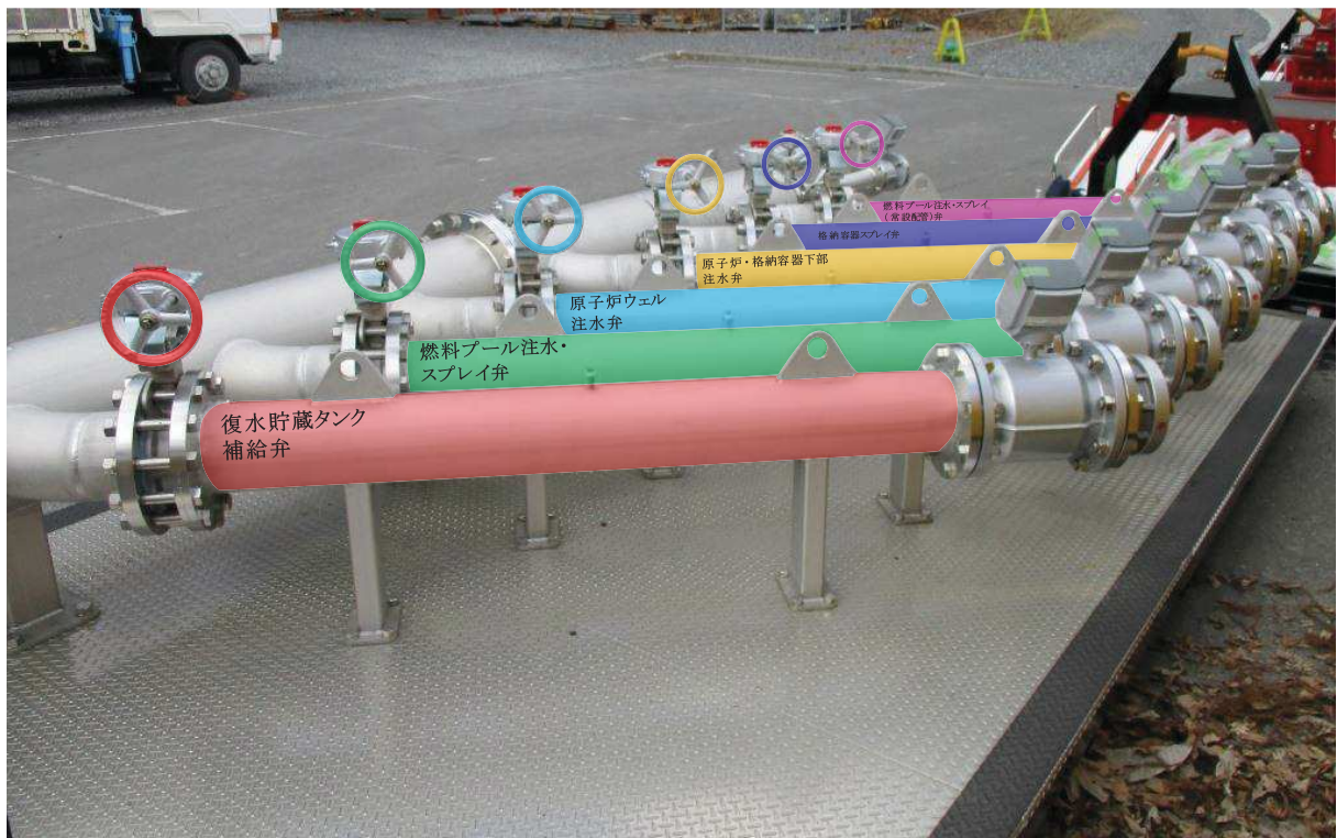
図 47-11-3 注水用ヘッドの誤接続及び誤操作の防止対策イメージ図
