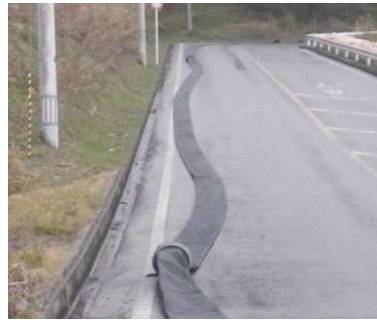
ホースの敷設、接続
