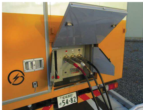
電源車ケーブル接続
