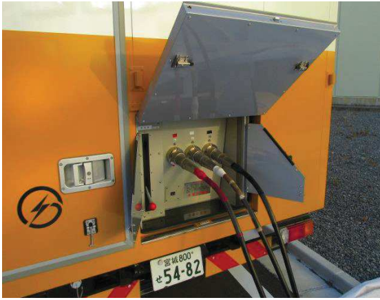
電源車ケーブル接続
