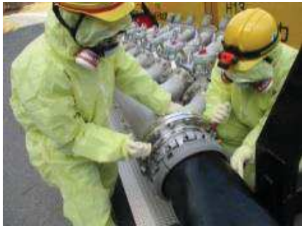
注水用ヘッドへのホース接続
