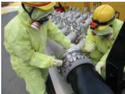
注水用ヘッダへのホース接続
