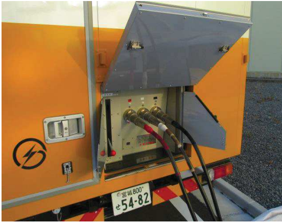
電源車ケーブル接続
