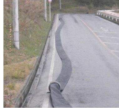
ホース敷設, 接続
