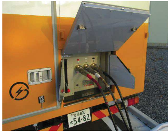
電源車ケーブル接続
