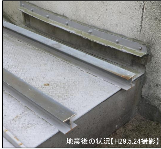
←1号炉SPTとT-11トレンチの接続部
