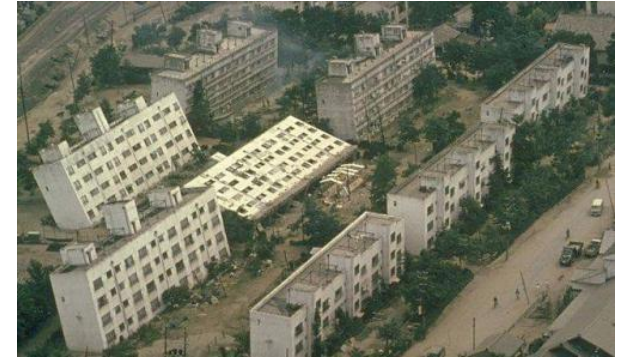
新潟地震で地盤の液状化現象により支持力を失って傾いた県営アパート※
