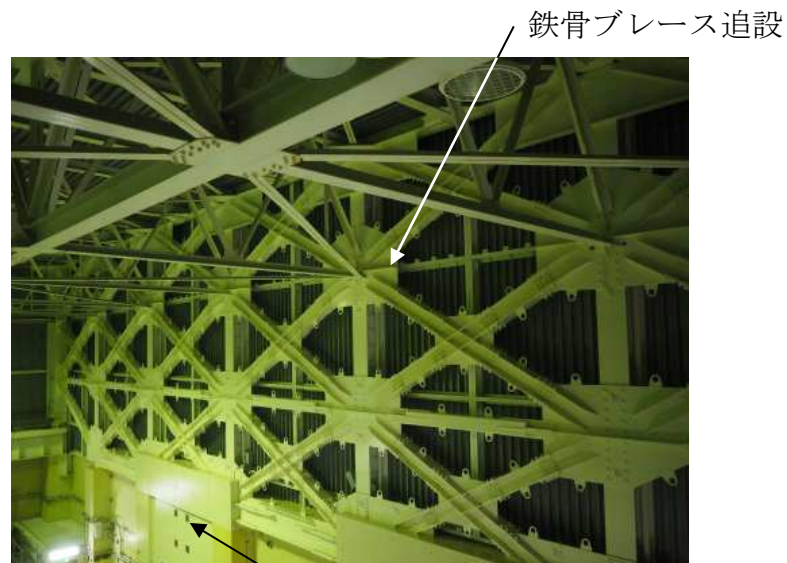
鉄骨ブレース追設 RC耐震壁増設 耐震補強工事状況
