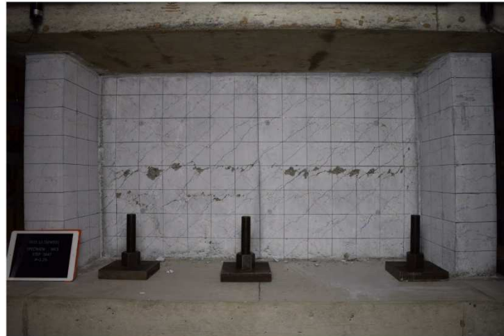
せん断すべり破壊している。
