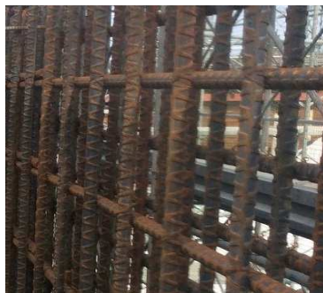
原子力発電所耐震壁の鉄筋
