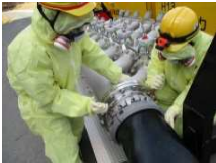
注水用ヘッダへのホース接続
