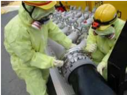
注水用ヘッダへのホース接続
