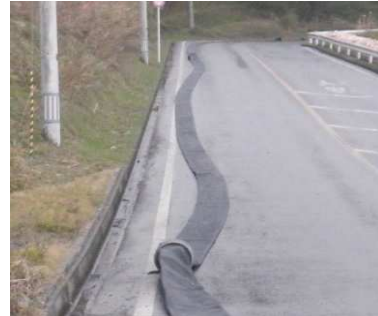
ホースの敷設, 接続
