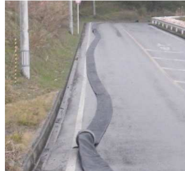
ホース敷設、接続
