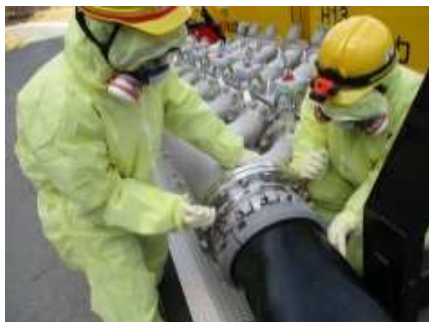
注水用ヘッダへのホース接続
