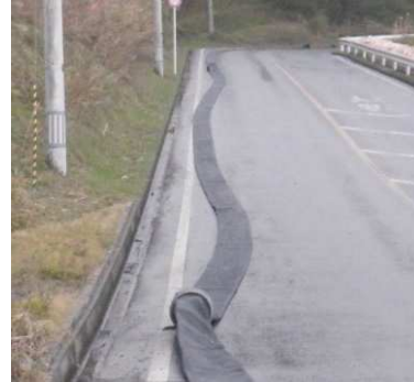
ホース敷設、接続
