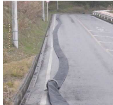
ホース敷設，接続（屋外）
