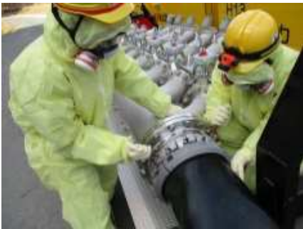
注水用ヘッドへのホース接続
