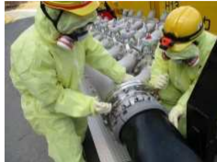
注水用ヘッドへのホース接続
