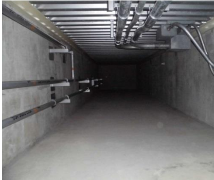
電線管及び配管
