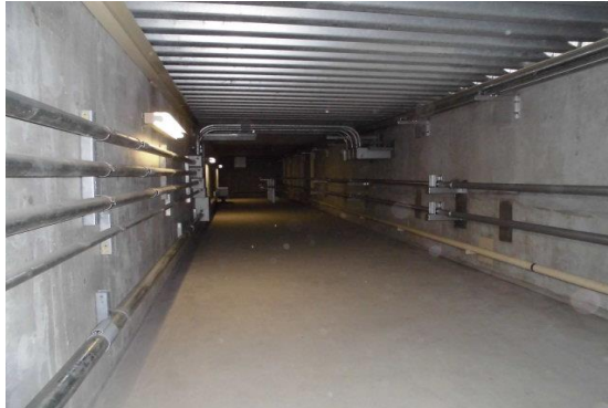
電線管及び配管
