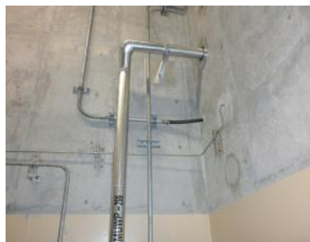
電線管及び可とう電線管
