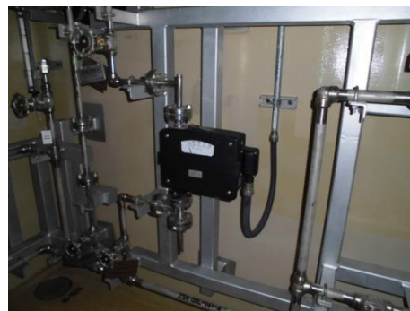
計器及び可とう電線管
