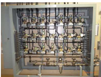
電磁弁架台
