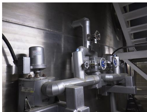
計器及び可とう電線管
