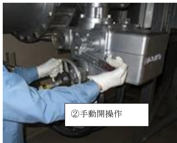
第5図 弁手動開操作例
