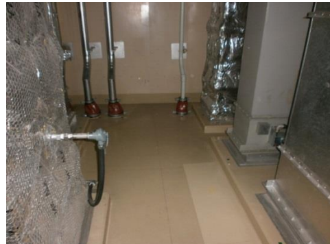
電線管及び可とう電線管
