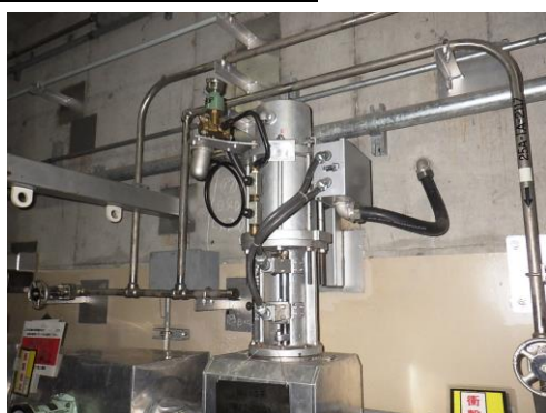
空気作動弁及び可とう電線管
