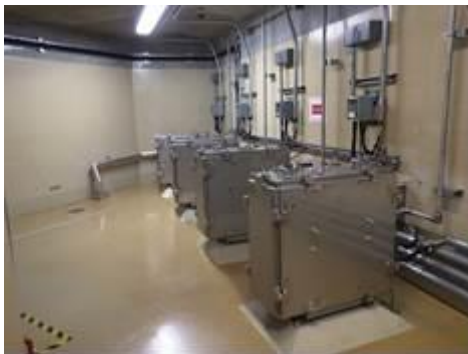
TIP 駆動装置及び可とう電線管
