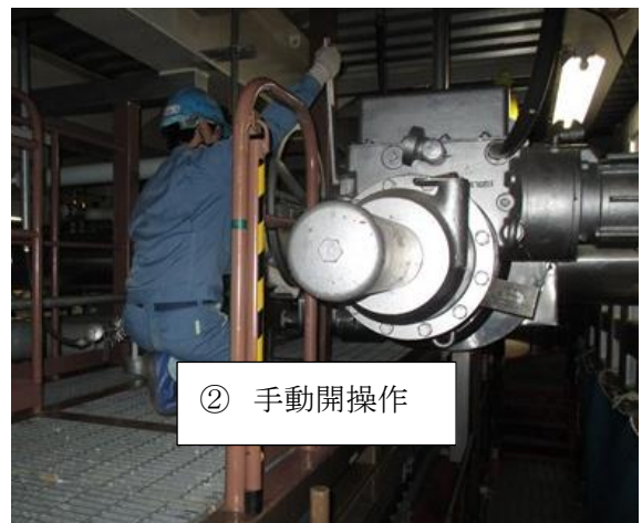
第3図 弁手動開操作例
