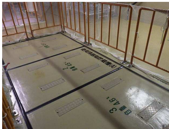
第 1-16 図：使用済樹脂貯蔵槽上部ハッチ
