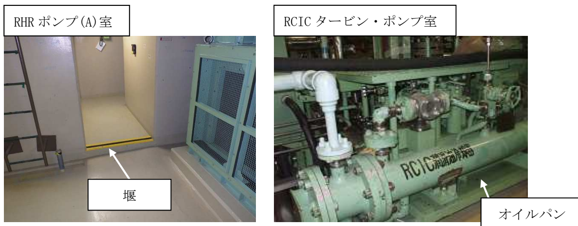
第 1-1 図：溶接構造，シール構造による漏えい防止対策概要図
