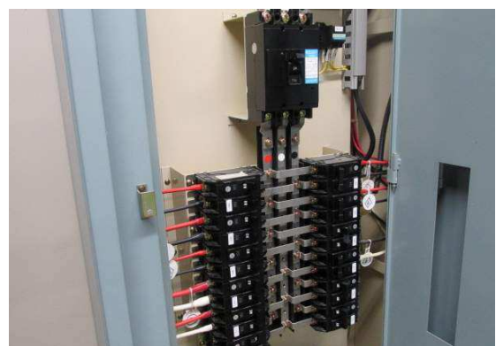
ブレーカ 種類：気中遮断器
