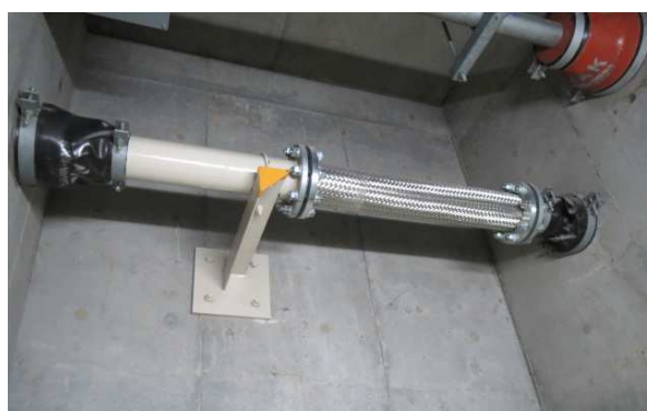
第1-33図：地盤変位対策の実施例
