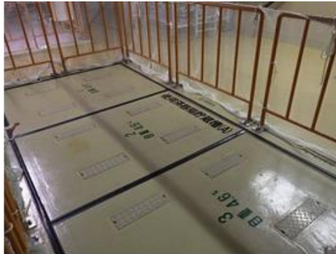
第 5-4 図：使用済樹脂貯蔵槽上部ハッチ
