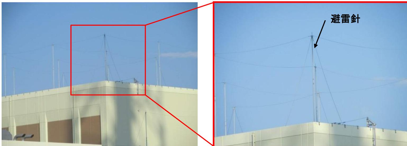
避雷設備の設置例(原子炉建屋)
