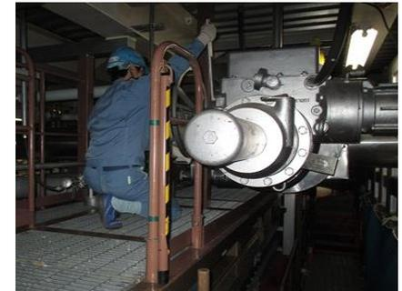
電動弁の手動ハンドルによる操作
