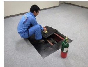
②床板取外し
