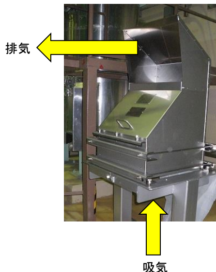
静的触媒式水素再結合装置
