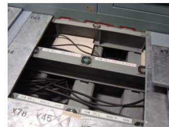
中央制御室床下ケーブルピットの構造
