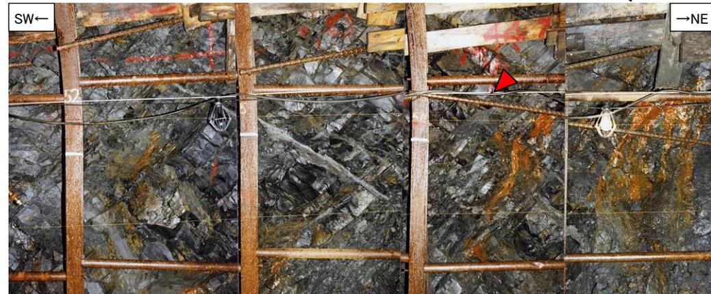
2号炉試掘坑B坑北西壁で確認したTF-3断層(下:写真, 右上:スケッチ)
