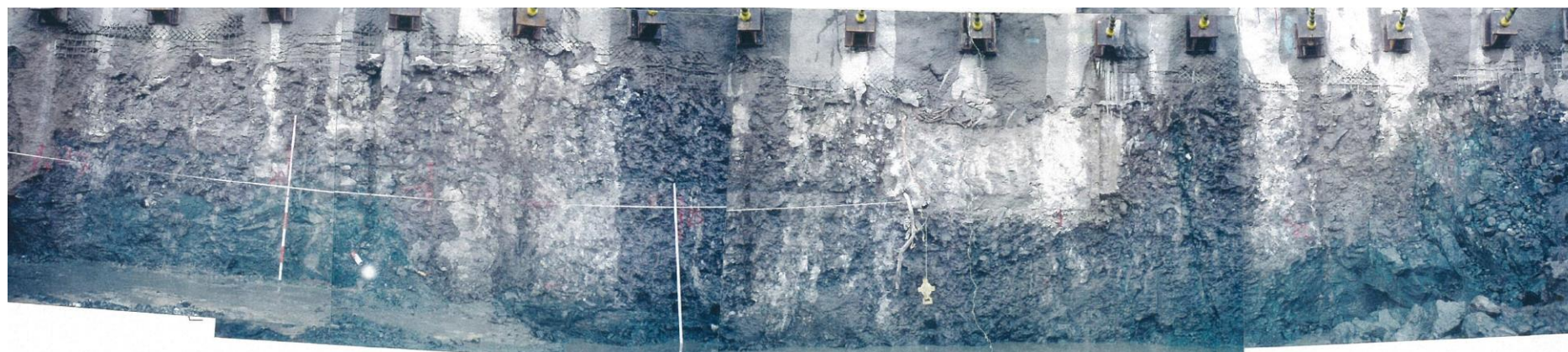
原子炉建屋南側法面写真(T.P.-14m~-17m)
