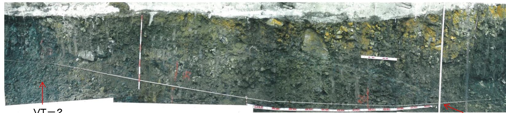
VT-2 ②タービン建屋北側法面写真(T.P.-2m~-4m)
